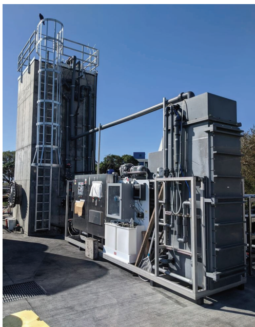
〈캘리포니아 Silicon Valley Clean Water에 설치된 실증화 규모 SAF-MBR 시스템〉
